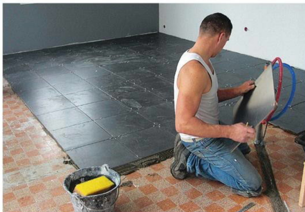
Du gros œuvre aux travaux de finition, comme la pose de carreaux dans la cuisine ouverte, Geoffroy a tout réalisé seul, sans se ménager. « J’ai attaqué en mai. Et en septembre, je finissais la couverture pour pouvoir travailler à l’intérieur durant l’hiver, réaliser l’isolation, le carrelage, etc. »
