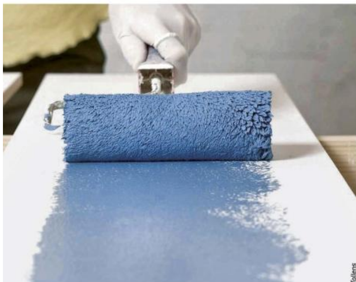
La peinture en phase aqueuse (à l'eau) est appliquée en bandes parallèles, en rechargeant le pinceau ou le rouleau à chaque passe, sans croiser. À la différence de la peinture en phase solvant.
