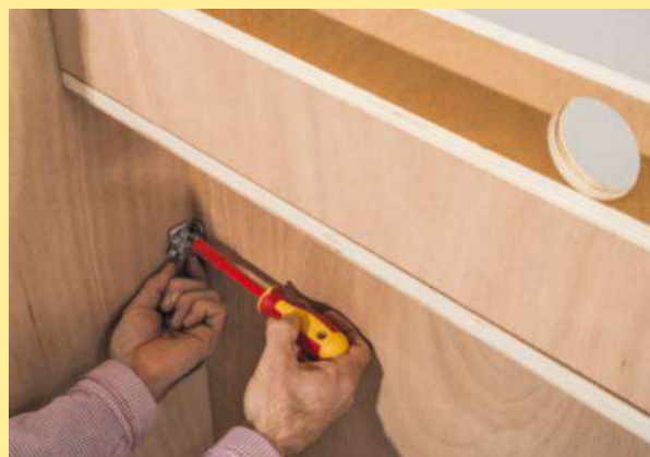
21 Montez la goulotte en même temps que l'ensemble de l'élément central à l'aide de tourillons et de connecteurs métalliques.
