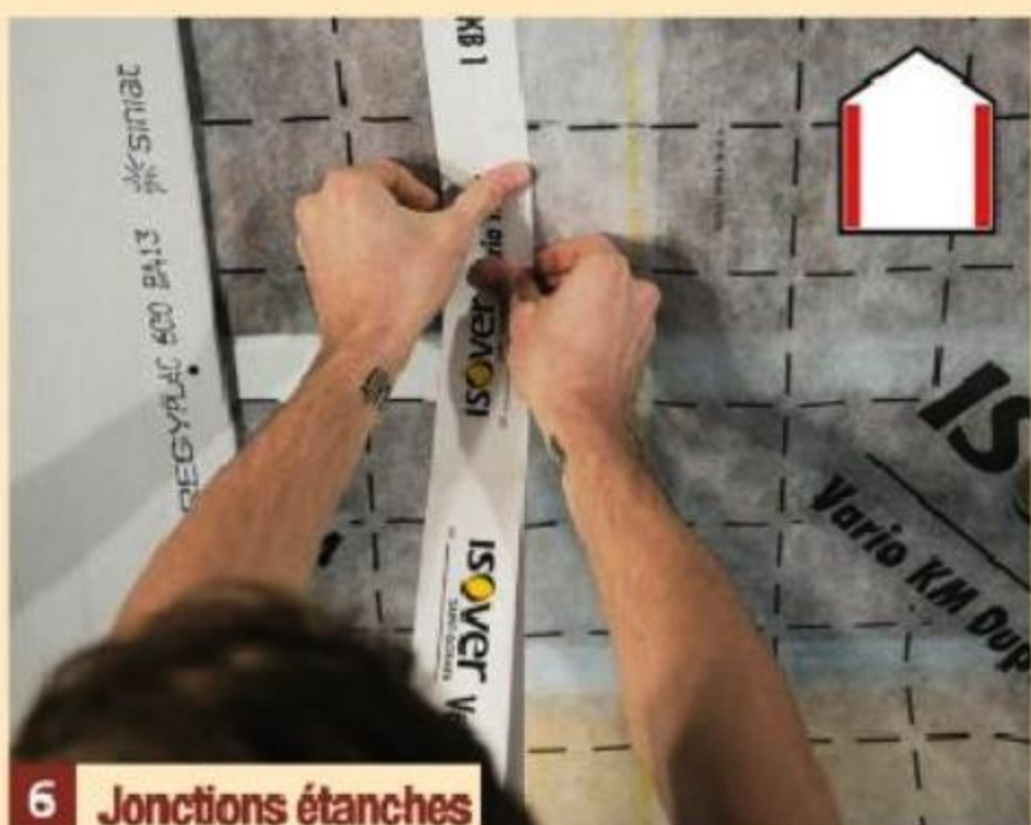
7 Isolation de mur sur ossature
