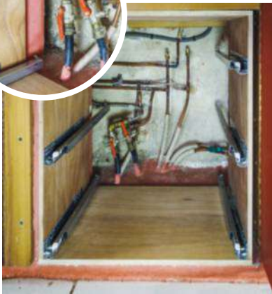
14 La présence de canalisations et de robinets d'arrêt oblige à laisser le caisson sans fond et à prévoir des tiroirs de profondeurs différentes (475, 635 et 670 mm).
