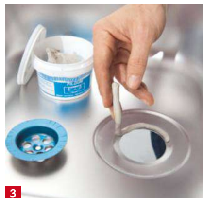
3 Déposez un cordon de mastic spécial bonde qui assurera l'étanchéité à l'intérieur du bac.
