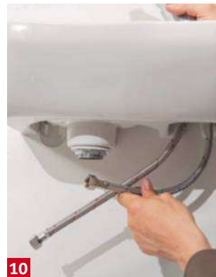
10 Équipez l'appareil de sa robinetterie. Reliez-la aux canalisations eau froide et eau chaude avec des flexibles.
