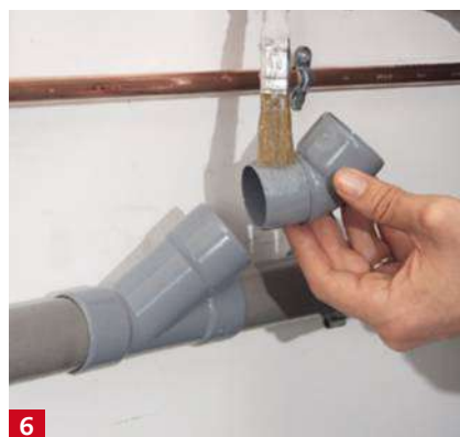
6 Poursuivez l'assemblage de l'évacuation en collant un raccord à 45° sur le raccord en Y.
