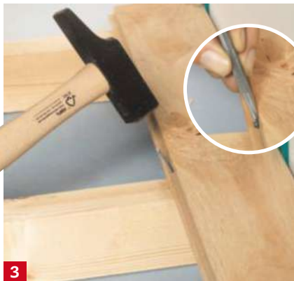
3 Pour clouer les lames sur les lambourdes, utilisez des pointes « tête d'homme » enfoncées en biais dans la languette. Chassez les têtes des pointes avec un chasse-clou pour ne pas gêner l'emboîtement de la lame suivante.
