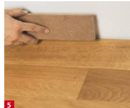
5 Après 24 h de séchage, vous pouvez réaliser les finitions : ponçage, fixation de la plinthe à la colle mastic, application d'un vitrificateur.
