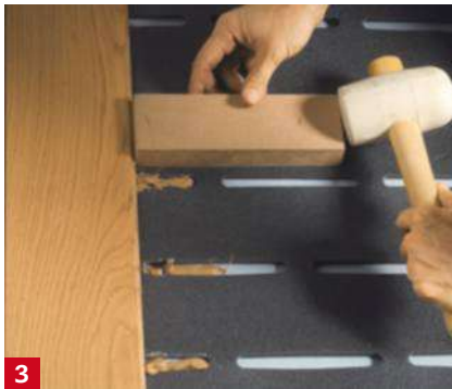
3 Posez les lames rangée par rangée, puis enfoncez-les bien les unes dans les autres en utilisant le maillet et une cale martyr en bois.
