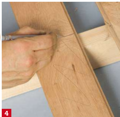
4 Posez la deuxième rangée de lames. Assurez-vous que les extrémités des lames se raccordent toujours au-dessus d'une lambourde. Faute de quoi le parquet risque de s'affaisser sous vos pas.
