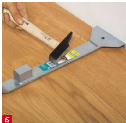
6 La dernière lame est emboîtée et serrée à l'aide d'une chasse métallique avant d'être clouée par-dessus (le clou sera ensuite dissimulé par la plinthe).
