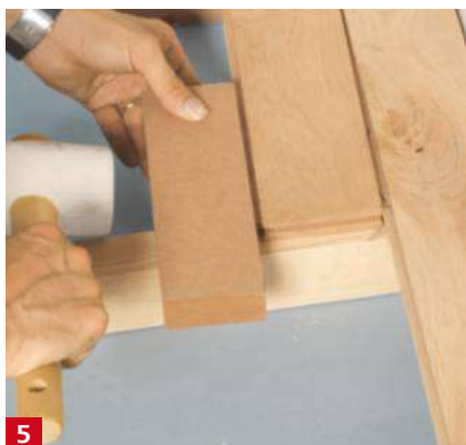
5 Enclenchez les lames avec une cale matyr (chute de lame ou cale rainurée) et un marteau pour ne pas endommager les languettes des lames.
