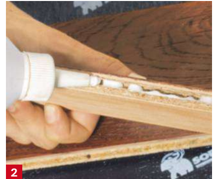
2 Encollez les rainures longitudinales et d'about de votre deuxième rangée de lame avec de la colle vinylique. Posez un cordon régulier.
