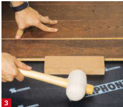
3 Emboîtez les lames les unes après les autres en utilisant une cale martyr et un maillet pour bien les enfoncer sans endommager les languettes.
