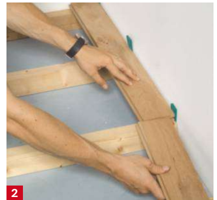
2 Commencez la pose en glissant des cales contre le mur. Respectez toujours un joint d'environ 5 à 8 mm autour des obstacles et des murs.
