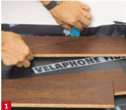
1 Posez sur la sous-couche une première rangée de lames (languettes vers vous) en conservant un jeu périphérique d'environ 8 mm (utilisez des cales).
