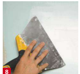
8 Pour finir, lissez à nouveau tout le périmètre avec un large couteau de peintre et faites disparaître la différence de niveau.
