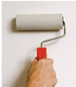
Avec une spatule ou un rouleau de caoutchouc, marouffez soigneusement la surface pour que le voile adhère au support. Laissez sécher.
