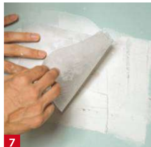
7 Appliquez une bande de calicot sur l'enduit encore frais. Lissez-la pour que l'enduit imprègne le calicot. Laissez sécher.
