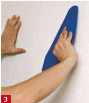
Avec une spatule ou un rouleau de caoutchouc, marouffez soigneusement la surface pour que le voile adhère au support. Laissez sécher.
