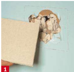
1 Découpez un morceau de plaque de plâtre largement plus grand que le trou à réparer. Puis reportez ses dimensions sur le mur.
