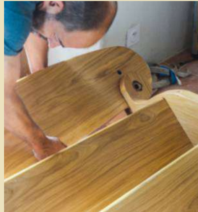
17 La première marche, ou marche de départ, comporte une échancrure côté limon de jour et poteau. Elle est placée sous la crosse et dans les rainures prévues à la base des limons.
