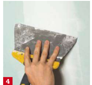
4 Lissez à nouveau pour faire disparaître la différence de niveau. Laissez sécher, puis poncez avant de peindre.
