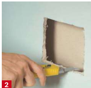
2 À l'aide d'une scie, découpez en suivant ce repère. Puis avec un cutter, élargissez légèrement cette découpe.
