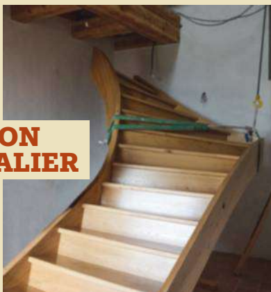
19 Toutes les pièces de l'escalier sont assemblées au sol à l'exception des poteaux et de la rampe. L'escalier est soulevé à l'aide du palan. Toute la difficulté consiste à élever progressivement un ouvrage aussi lourd et volumineux, s'ajustant précisément aux dimensions de la trémie, sans cogner les murs.
