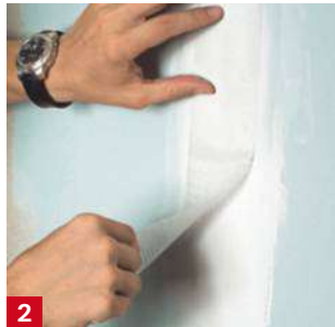
2 Déroulez et collez méticuleusement une bande de calicot par-dessus l'enduit encore frais.
