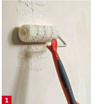
1 Sans ouvrir les fissures, appliquez la colle avec un rouleau ou un pinceau sur une largeur d'environ deux lés.
