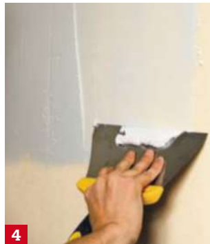
Appliquez trois ou quatre passes d'enduit suivant le degré de finition souhaité.
