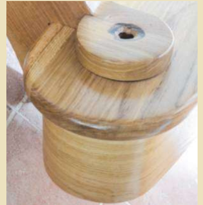
18 Fixez le patin sous la marche. Cette pièce courbe est obtenue en contrecollant plusieurs planches assez fines pour pouvoir être courbées sur un gabarit de serrage.
