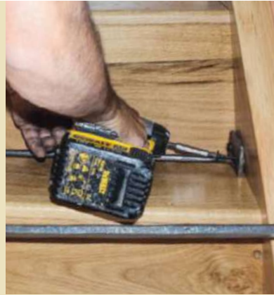
15 Par mesure de sécurité, les limons de mur et de jour sont reliés par une tige métallique. Une plaque à visser est fixée sur la face intérieure du limon de jour, l'autre extrémité filetée traverse le limon de mur et est serrée par un écrou noyé dans l'épaisseur du bois.
