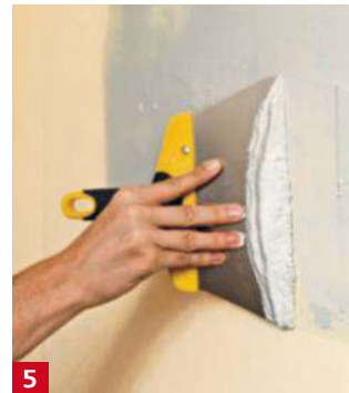
Alternez passes verticales et horizontales. Si besoin, poncez...
