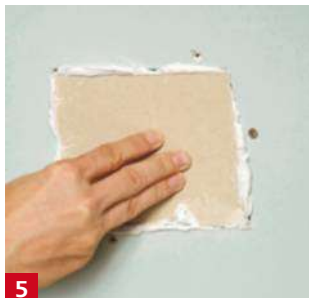
5 Positionnez le morceau de plaque de plâtre (vissez-le si besoin). Colmatez le joint et enlevez l'excédent d'enduit.
