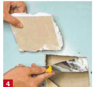
4 Appliquez une couche d'enduit sur les quatre tranches de la plaque ainsi que sur les deux supports d'angle.
