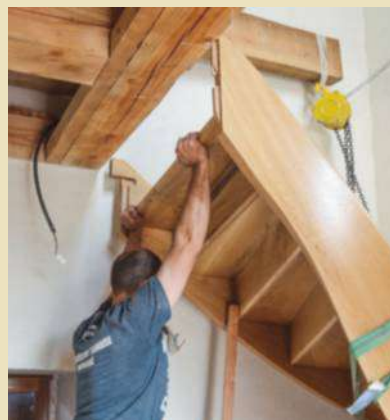
19 Toutes les pièces de l'escalier sont assemblées au sol à l'exception des poteaux et de la rampe. L'escalier est soulevé à l'aide du palan. Toute la difficulté consiste à élever progressivement un ouvrage aussi lourd et volumineux, s'ajustant précisément aux dimensions de la trémie, sans cogner les murs.
