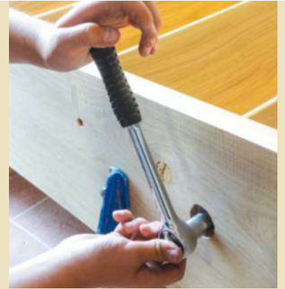
15 Par mesure de sécurité, les limons de mur et de jour sont reliés par une tige métallique. Une plaque à visser est fixée sur la face intérieure du limon de jour, l'autre extrémité filetée traverse le limon de mur et est serrée par un écrou noyé dans l'épaisseur du bois.
