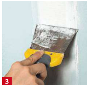
3 Lissez avec un couteau à enduire pour que le produit imprègne le calicot. Laissez sécher.
