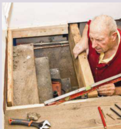
10 Insérez le madrier dans les sabots et contrôlez son niveau avec les tasseaux périphériques. Glissez des cales de montage si besoin, puis vissez le madrier dans les sabots.
