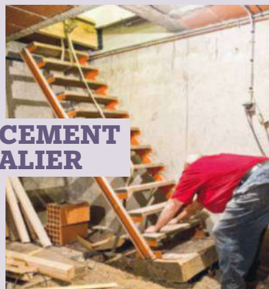
13 Pour déplacer l'escalier et faire coïncider la marche du haut contre le madrier mis en place, attachez l'escalier avec une sangle en haut et tirez depuis le bas.
