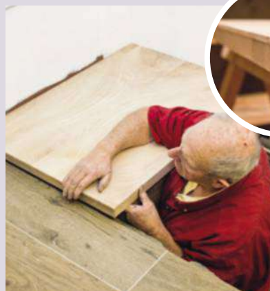
11 Mesurez puis découpez le plateau en chêne (ép. 38 mm) servant de palier. Au rabot, creusez la tranche du plateau sur la largeur afin de couvrir légèrement le carrelage au sol.
