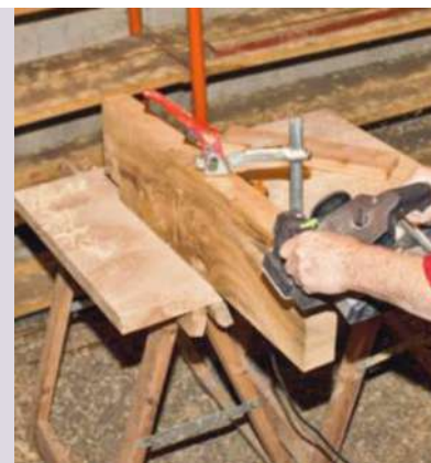
9 À la scie circulaire, découpez une section de madrier (ici en chêne) à insérer entre les deux sabots métalliques. Rabotez la pièce pour l'ajuster si nécessaire.
