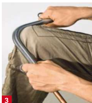
3 Prenez appui sur votre genou et pliez le tube jusqu'à l'angle souhaité.
