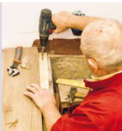
7 Dans la réservation prévue, fixez un tasseau au bord de la dalle. Laissez un jeu de 5 mm entre le tasseau et le carrelage.
