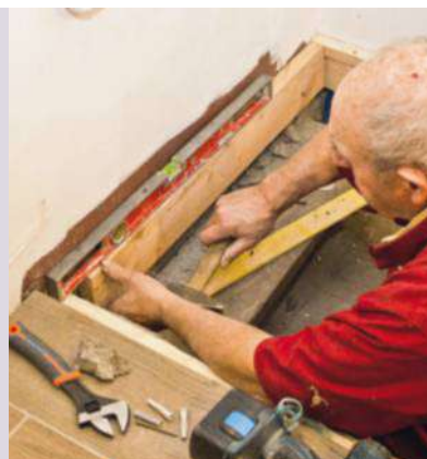
8 Percez, chevillez, puis vissez une section de bois sur le mur situé face à l'escalier, au même niveau que le tasseau précédemment fixé.
