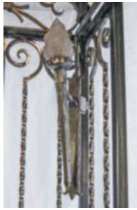
Façonnées à la main à partir de fers plats, quatre torches électriques prennent place sur les montants.
