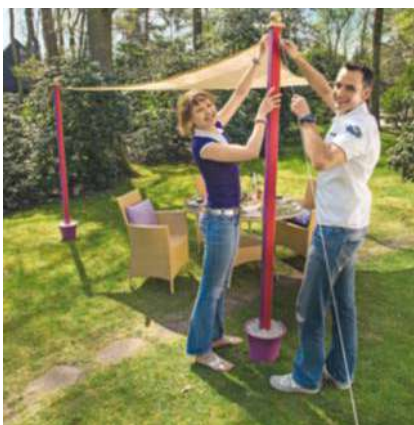
7/ Au sommet de chaque poteau, fixez deux crochets en vis-à-vis. Celui de l'extérieur recevra la cordelette de tension en Nylon que vous riverez au sol par des sardines. L'autre servira à l'accrochage du voile d'ombrage. Il est plus facile de procéder à deux.
