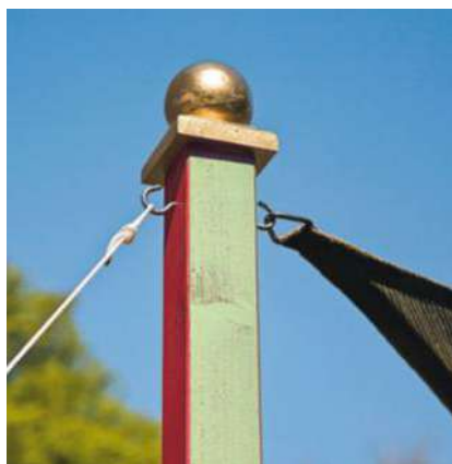
7/ Au sommet de chaque poteau, fixez deux crochets en vis-à-vis. Celui de l'extérieur recevra la cordelette de tension en Nylon que vous riverez au sol par des sardines. L'autre servira à l'accrochage du voile d'ombrage. Il est plus facile de procéder à deux.
