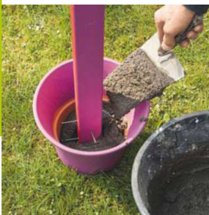
5/ Fixez des vis dans le bois pour renforcer le scellement. Versez le béton dans le pot jusqu'à 10 cm du bord. Travaillez sur une surface plane et vérifiez l'aplomb à l'aide d'un niveau.
