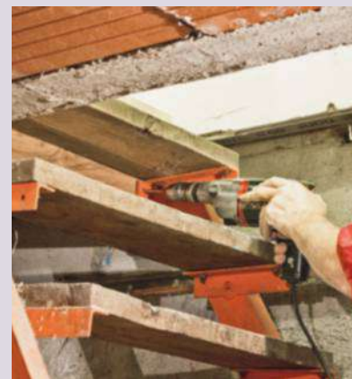
14 Sous la première marche du haut de l'escalier, il faut percer la platine d'ancrage des limons métalliques, pour les visser dans le madrier avec des vis à bois.
