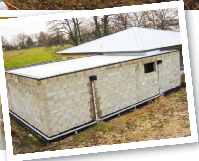
Les fermettes industrielles sont mises en place. Les combles, qui ne seront pas aménagés, seront isolés par 45 cm de ouate de cellulose. La couverture en bacs acier a été posée par le constructeur. Mais c'est notre lecteur qui s'est chargé de l'étanchéité du toit plat contigu, « qui permet de dissocier les deux zones, habitation et garage ».
