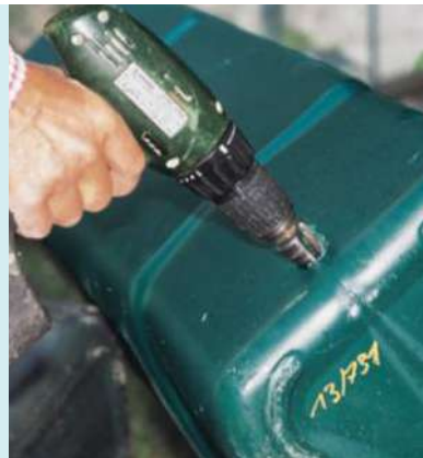
2 Pour installer les raccords et relier les cuves, percez les trous et agrandissez-les avec une fraise conique.
