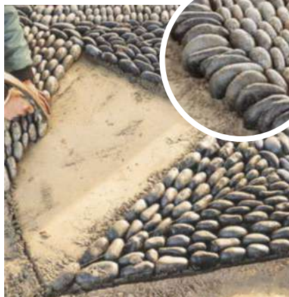
6/ Remplissez de galets plus clairs les zones entre les branches. Disposez-les en suivant le tracé. L'extérieur est réalisé avec de gros galets noirs dirigés vers le centre du décor.
