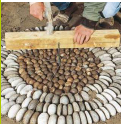
3/ Remplissez le centre avec des galets foncés posés à la verticale. Mettez les pierres de niveau à l'aide d'une cale.
