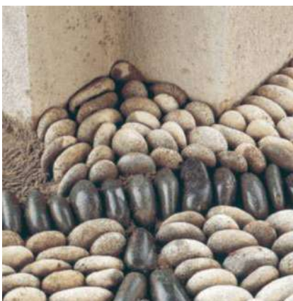
7/ Garnissez les recoins avec des galets de petite taille, plus faciles à insérer. Contrôlez le niveau des pierres et ajustez-les si nécessaire.
