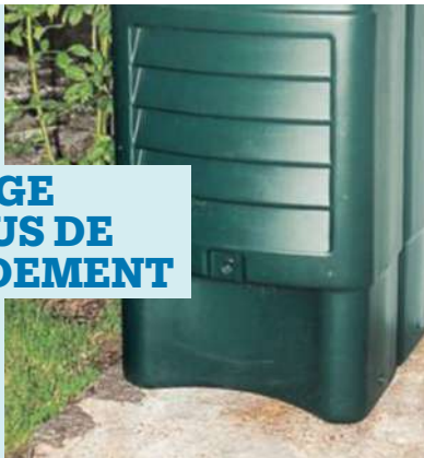
1 Serrez l'une contre l'autre les deux cuves de 200 litres. Elles reposent sur la dalle, à proximité de la descente d'eau pluviale.
