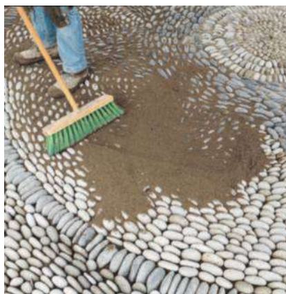
8/ Pour jointoyer les galets, étalez du sable (ou de la terre) à l'aide d'un balai ou appliquez un mélange fluide de ciment et d'eau (barbotine).
