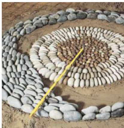
4/ Tracez un deuxième cercle de 110 cm de rayon. Tout en suivant le tracé, placez les galets perpendiculairement aux premiers. Procédez par zone.
