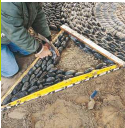
5/ Tracez un troisième cercle de 195 cm de rayon. Disposez deux planches réglées de niveau pour réaliser les branches de l'étoile. Garnissez en commençant par la pointe.
