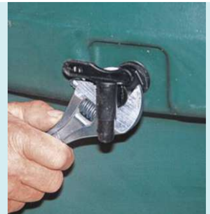
3 L'emplacement du robinet est prévu en face avant. Enroulez du ruban Téflon sur le filetage pour assurer l'étanchéité.
