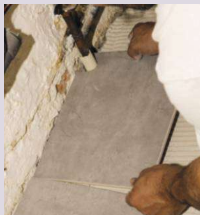
20 Contournez un tuyau, grâce à une encoche en U réalisée avec une scie cloche (trépan diamanté), au diamètre du tuyau + 5 mm. Terminez par deux traits de meuleuse à partir du bord.
