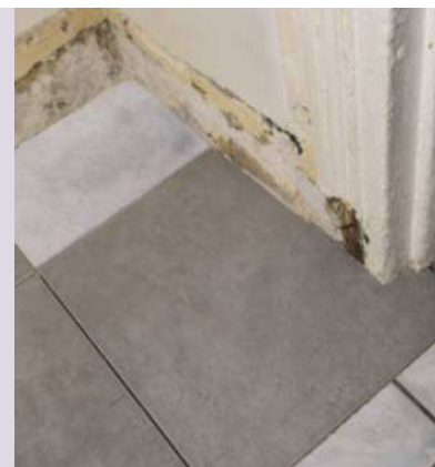
18 Naturellement, faites un essai à blanc avant d'encoller l'emplacement et le carreau retaillé...
