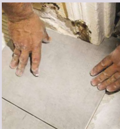
19 Si vous avez encore besoin d'ajuster, utilisez à nouveau la meuleuse ou une pince spéciale (bec-de-perroquet). Encollez et placez votre carreau.
