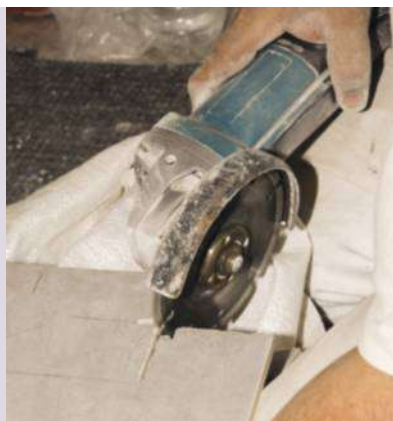
17 Pour les coupes les plus courtes, le plus pratique est d'utiliser une meuleuse Ø 125 mm. Installez-vous sur un support stable, par exemple sur un établi pliant. Terminez à la carrelète.
