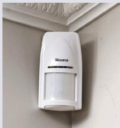
11 Il est conseillé de placer chaque détecteur à environ 2 m de hauteur dans un angle de la pièce. Réglez l'angle d'inclinaison pour optimiser le balayage. Apparez le détecteur à la centrale.
