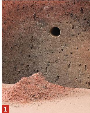
1 Si la poussière de forage est de couleur ocre ou rouge, pas de doute : votre mur est en brique.
