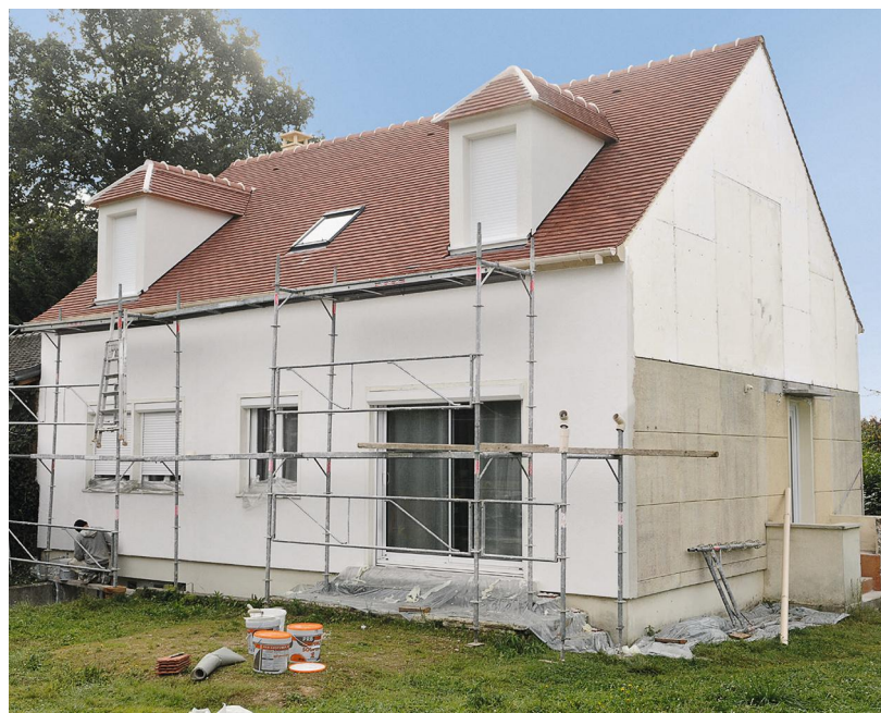
La surélévation de la charpente est réalisée avec des éléments métalliques similaires à ceux de l'ossature. Les parois verticales sont habillées de panneaux doublés d'un isolant mince qui sert de support à l'enduit.
