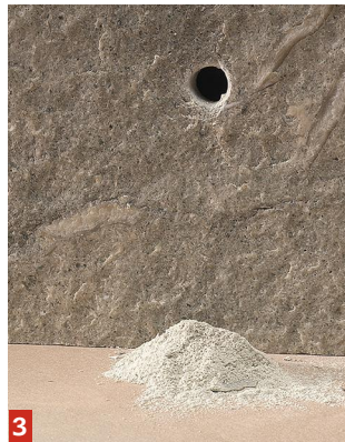
3 La poussière est beige ou blanche et sablonneuse : il s'agit d'un mur construit en pierre calcaire.
