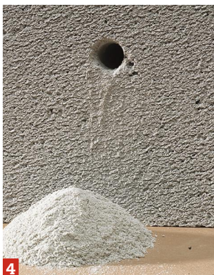
4 La poussière est blanche, grossière et légèrement grasse : il s'agit d'un mur en béton cellulaire.
