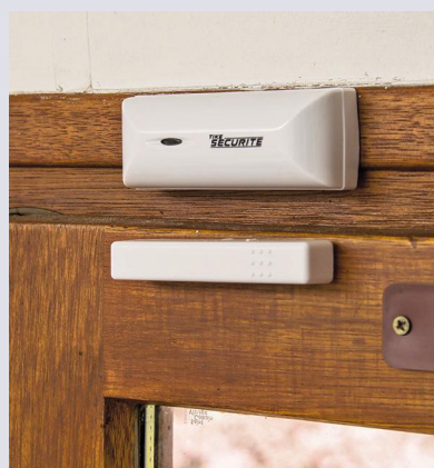
9 Fixez le transmetteur sur le châssis fixe (fenêtre) ou le cadre de la porte et la bande magnétique sur l'ouvrant. Suivez les instructions pour activer le mode « auto-code ».
