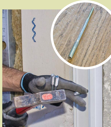
10 Placez des chevilles dans chaque trou, puis enfoncez au marteau vos vis de fixation à double filetage (avec âme centrale lisse) jusqu'à sentir une résistance lors de la frappe.
