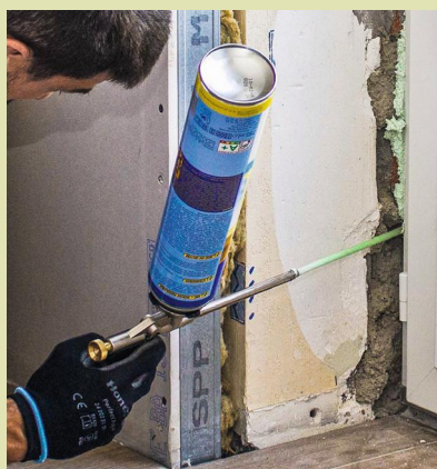
13 À l'intérieur, l'espace entre la maçonnerie et le dormant est comblé à la mousse expansive. L'idéal est d'appliquer un joint (type Comprimband, voir p. 24). Arasez au cutter après séchage.
