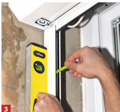
3 Contrôlez à l'aide d'un niveau à bulle la verticalité des coulisses et l'horizontalité du coffre. Repérez les points de fixation sur la maçonnerie.
