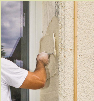
17 À l'aide d'un platoir, appliquez de l'enduit de façade avec une truelle ronde en commençant par les deux tableaux, puis en poursuivant par la sous-face du linteau.
