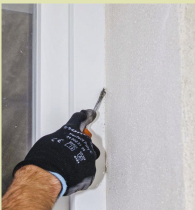
20 Dégraissez le PVC à l'essence F et creusez légèrement l'enduit entre la maçonnerie et le dormant avec un tournevis plat. Aspirez, et posez votre joint d'étanchéité en périphérie.
