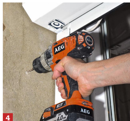
4 Percez la maçonnerie avec une mèche à béton Ø 5 mm. Insérez des chevilles adaptées au matériau (pierre, parpaing, brique).
