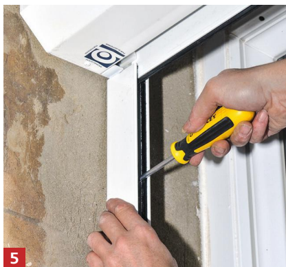
5 Fixez les coulisses à la maçonnerie. Utilisez de préférence un tournevis afin de ne pas détériorer, avec le mandrin, les bords et les patins des coulisses.
