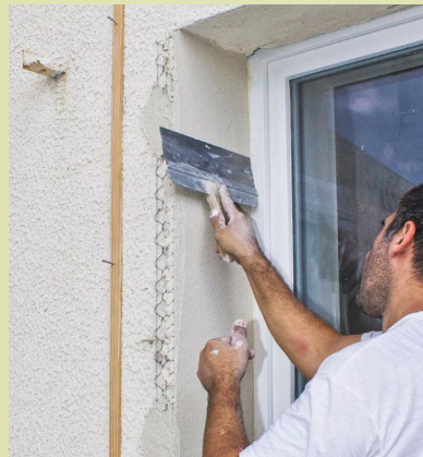
18 Au fur et à mesure de l'application de l'enduit, lissez en utilisant un couteau d'enduseur ou un couteau de peintre doté d'une lame suffisamment rigide.
