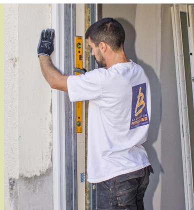
7 Positionnez le dormant dans le mastic frais, et redressez-le vers le linteau. Calez-le en haut avec un serre-joint (voir astuce). Vérifiez l'aplomb à la règle et au niveau.
