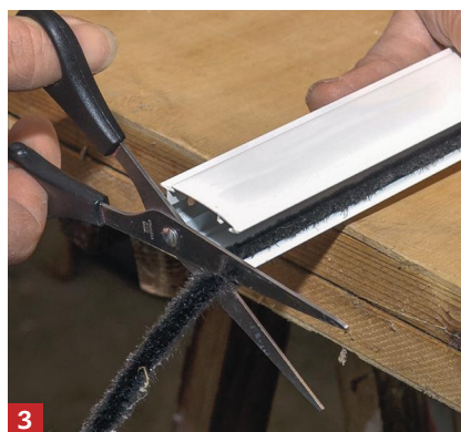
3 Recoupez les coulisses à dimension avec une scie à métaux. Insérez les patins dans les gorges prévues à cet effet. Coupez l'excédent avec un ciseau.
