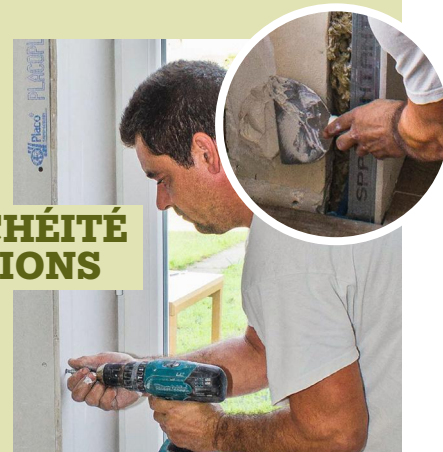
14 Habillez le tableau et la sous-face du linteau en vissant des sections de plaques de plâtre dans l'ossature de la contre-cloison isolante intérieure.
