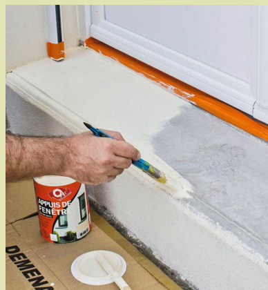
21 Terminez en appliquant au pinceau plat et à la patte de lapin deux couches de peinture pour appui de fenêtre sur le seuil maçonné dans une teinte proche de celle de l'enduit.
