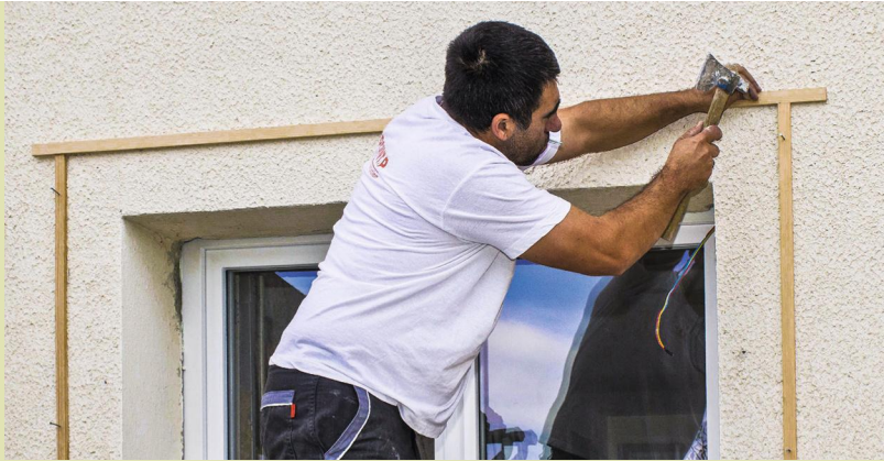
15 Sur la façade, clouez des tasseaux en bois (ép. 10 mm) avec des pointes à béton de façon à former un cadre à 15 cm de la nouvelle baie. Dans une auge, préparez au malaxeur votre mortier d'enduit monocouche.
