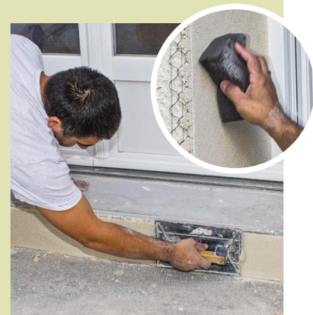
19 Procédez de même pour l'encadrement en façade. Talochez l'enduit quand il commence à tirer et passez une éponge légèrement humide. Laissez sécher avant de poser le joint.
