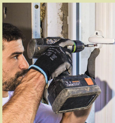
12 Retirez les serre-joints placés en partie haute, puis remettez en place chaque ouvrant sur les paumelles du dormant. Vissez ensuite la poignée de la porte-fenêtre.
