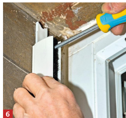
6 Vissez les coulisses équipées de leurs réglettes et insérez l'enrouleur. Plaquez-le contre le linteau, puis bloquez sa position.
