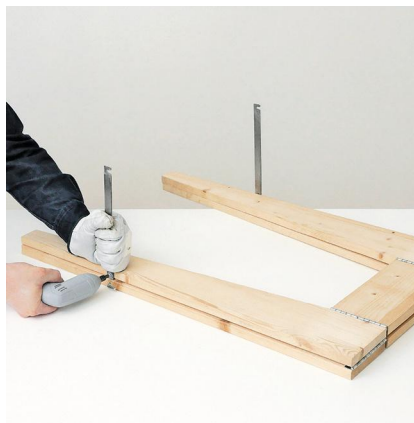
8/ Toujours à 24 cm du bas, fixez le compas avec une vis à tête bombée en intercalant de chaque côté une rondelle afin de faciliter l'articulation. Appliquez ensuite la finition de votre choix.
