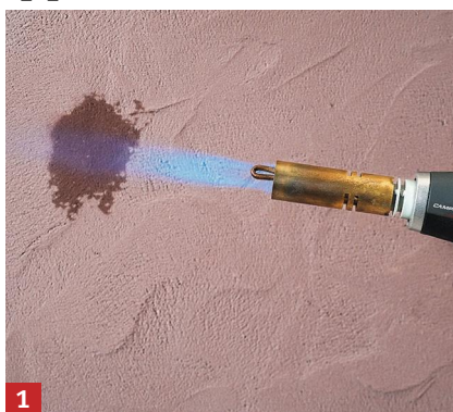
1 Chauffez une dizaine de secondes au chalumeau le revêtement de surface sur environ 10 cm de diamètre.
