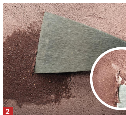
2 Enfoncez un couteau de peintre dans le mur pour juger de la plasticité du revêtement.
