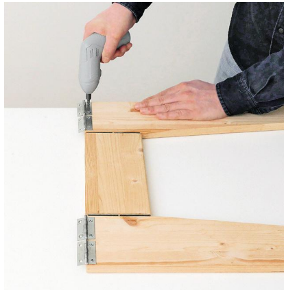
4/ L'articulation verticale se fixe sur le sommet des pieds. Déployez le premier demi-tréteau, retournez-le et vissez les quatre charnières (vis courtes pour ne pas dépasser l'épaisseur du bois).
