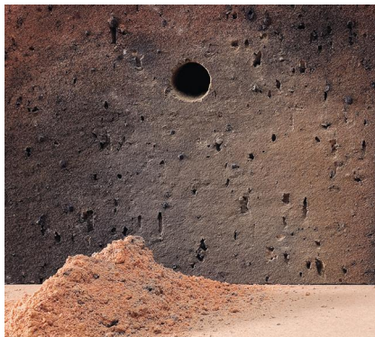
Si la poussière de forage est rouge, pas de doute, le mur est construit en briques.
