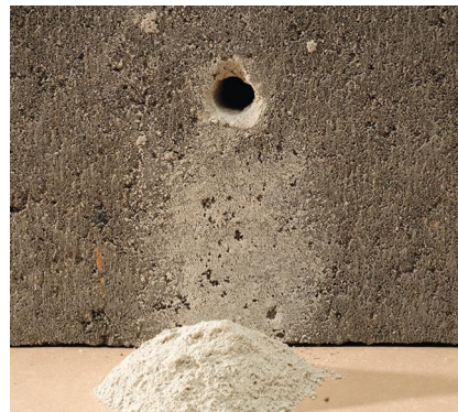
Si la poussière de forage est fine, de couleur blanche ou grise et qu'elle ruisselle : il s'agit d'un mur en béton.
