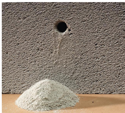
Si la poussière de forage est blanche, grossière et légèrement grasse, c'est un mur en béton cellulaire.
