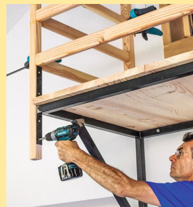
29 Vissez les bases des poteaux contre les platines de la console. Des vis 3,5 x 50 mm placées en biais fixent les marches dans les rainures et limitent la déformation des limons.
