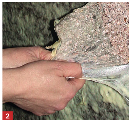
2 Après un temps de polymérisation d'au moins 24 h, retirez à la main le film élastique qui retient les salissures.
