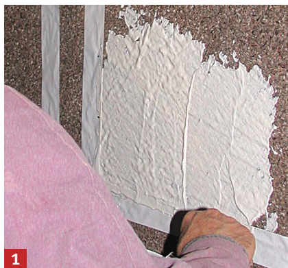
1 Appliquez à la brosse une couche de pâte à base de latex. Ce produit pelable prêt à l'emploi est spécifique au béton.
