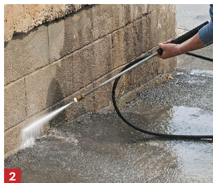
2 Laissez agir et sécher le savon pendant au moins 12 h puis rincez au nettoyeur haute pression (< 60 bars).
