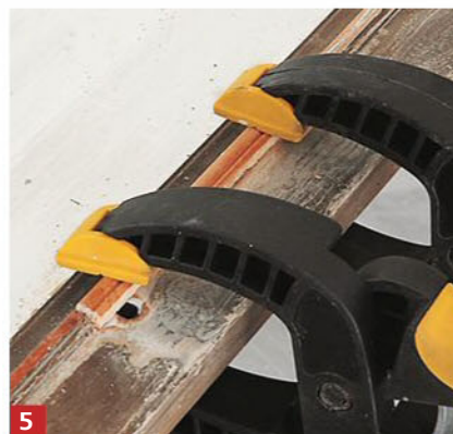
5 Fixez à la colle blanche une baguette de bois dans l'alignement de la moulure existante. Serrez le tout au serre-joint le temps de la prise.
