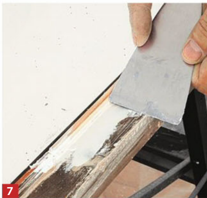
7 Utilisez un mastic de remplissage pour masquer le raccord entre la baguette et la moulure d'origine. Il permet aussi de masquer les petites erreurs de taille.
