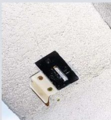
24 En bas et en haut, butées et gâches sont distinctes. Elles sont donc fixées consécutivement: d'abord les butées (en tenant compte de l'épaisseur du volet), puis les gâches qui imposent de percer la maçonnerie pour accueillir les pénes.
