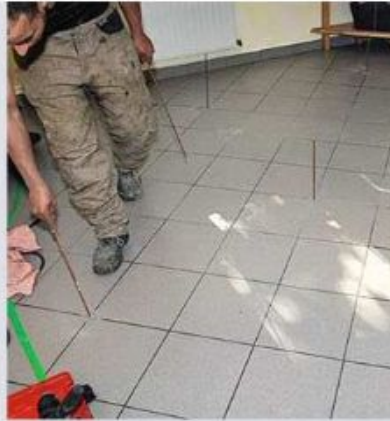
13 Comme pour le traitement extérieur, le technicien introduit ensuite les tubes d'injection qui serviront à acheminer la résine sous le sol intérieur de la pièce à traiter.
