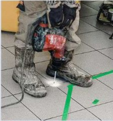
12 Des percements ( \varnothing 6 mm) sont effectués dans les joints du carrelage. Ils doivent traverser le revêtement de sol, la chape et la dalle.
