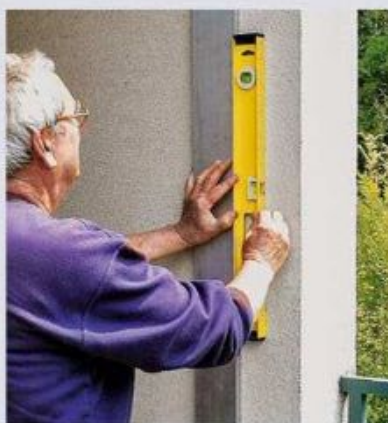
9 Utilisez des chevilles métalliques à expansion. Vissez légèrement les gonds dans les chevilles. Présentez les chevilles pour qu'elles se maintiennent puis vérifiez leur alignement. Retirez les gonds des chevilles, puis frappez ces dernières pour les faire entrer dans les trous et visser à fond les gonds. Vérifiez à nouveau leur alignement à la règle de maçon et au niveau.
