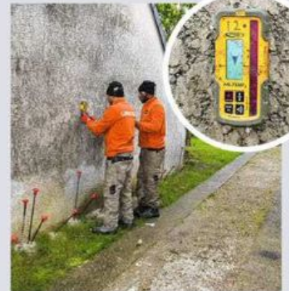
5 L'usage d'un niveau laser permet de suivre en temps réel l'effet des injections de résine, mais aussi de surveiller le comportement global du bâtiment.
