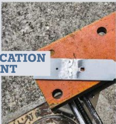
11 Devenues trop longues, les contre-pentures sont coupées côté gonds. Meulez les chants avant soudage et opérez un chanfrein sur les pièces à assembler. Meulez les cordons.
