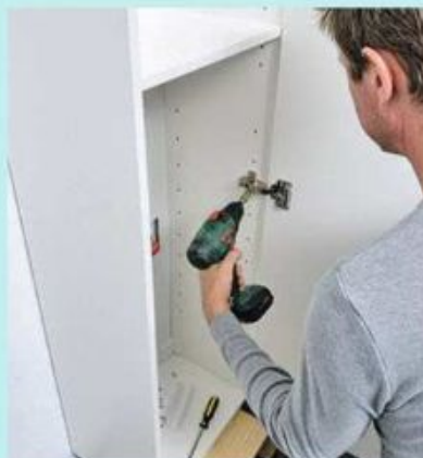
23 Installez les portes en les montant sur quatre charnières invisibles réparties dans la hauteur. Ensuite, il ne reste plus qu'à retirer le banc et le tour est joué!
