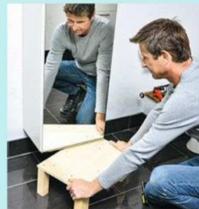
23 Installez les portes en les montant sur quatre charnières invisibles réparties dans la hauteur. Ensuite, il ne reste plus qu'à retirer le banc et le tour est joué!
