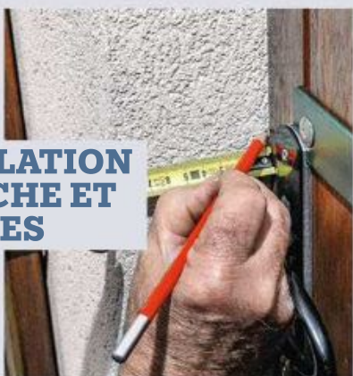
22 Fermez le volet afin de repérer et tracer l'emplacement de la butée faisant également office de gâche pour le pêne principal de la serrure.
