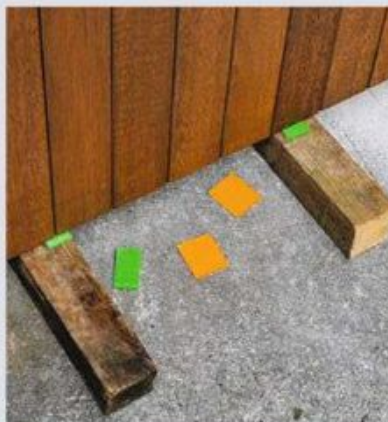
12 Installez les pentures sur leurs gonds. Puis calez le volet d'aplomb, perpendiculairement par rapport à la maçonnerie. Vérifiez avec une équerre ; en appui sur une planche si le grain du crépi est grossier.
