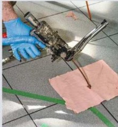
14 L'opération commence par l'injection de résine tout en contrôlant le relevage au niveau laser avec une précision de l'ordre du demi-millimètre. Durant l'intervention, une protection est également disposée autour des tubes d'injection pour protéger le revêtement de sol.
