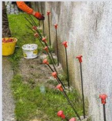
4 Dans chacun des trous qui serviront à acheminer la résine injectée dans le sol, l'opérateur introduit, à la main ou par « vibro-fonçage » – en s'aidant du perforateur en mode percussion – les tubes d'injection en acier. Des bouchons de sécurité sont placés à l'extrémité de chaque tube pour éviter aux techniciens de se blesser durant l'opération.
