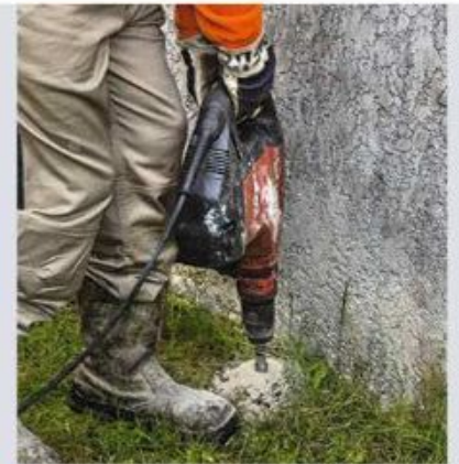
3 Des percements de \varnothing 18 mm sont effectués tous les 45 cm au perforateur-burineur, avec un angle de 10^\circ par rapport au mur, afin d'optimiser la pénétration de la résine expansive.
