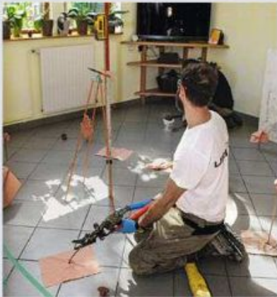
14 L'opération commence par l'injection de résine tout en contrôlant le relevage au niveau laser avec une précision de l'ordre du demi-millimètre. Durant l'intervention, une protection est également disposée autour des tubes d'injection pour protéger le revêtement de sol.
