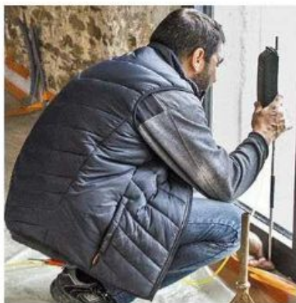
4/ Ensuite, la hauteur de la chape est vérifiée par rapport au seuil des portes-fenêtres en prenant en considération l'épaisseur du revêtement de sol qui sera posé (ici un carrelage collé).
