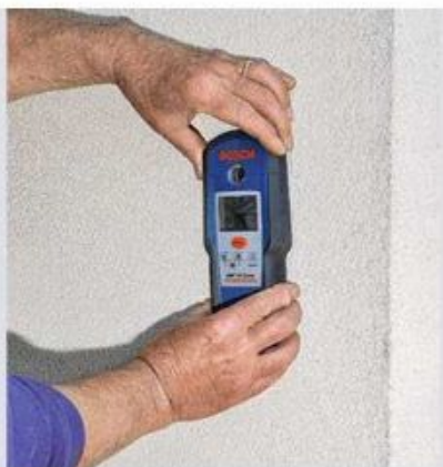
7 Veillez à vérifier les zones de perçage avec un détecteur de masses métalliques. Si vous tombez sur un fourreau électrique, décalez les repères de 3 cm au moins.
