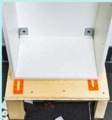
22 Assemblez et calez d'aplomb le placard colonne, à l'emplacement voulu. Ici, un banc a été confectionné pour maintenir le placard, le temps de le fixer au mur. Chevillez et vissez.
