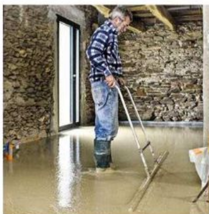
8/ Les trépieds sont retirés, puis commence le « débullage » soigneux de la chape. La barre est déplacée, m 2 par m 2 , pour bien faire remonter les bulles d'air en surface.
