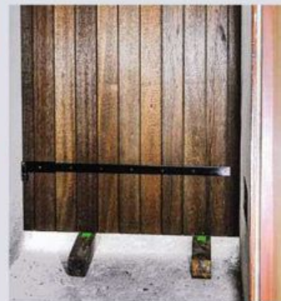
12 Installez les pentures sur leurs gonds. Puis calez le volet d'aplomb, perpendiculairement par rapport à la maçonnerie. Vérifiez avec une équerre ; en appui sur une planche si le grain du crépi est grossier.
