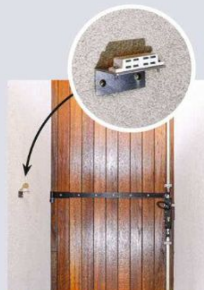
25 Un arrêt (magnétique) d'ouverture est posé à l'intérieur. Il est ici réalisé avec une chute de cornière en aluminium ou acier, sur laquelle est vissé un simple aimant.
