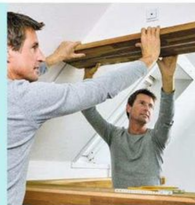
21 La tablette supérieure est fixée au mur par tourillons (voir encadré ci-dessous). L'extrémité correspondant au rampant est biseautée à la scie circulaire.
