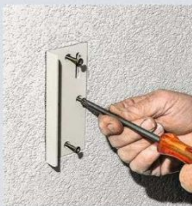
23 En forme d'équerre, la butée-gâche assure le verrouillage à mi-hauteur du volet. Ici, elle doit être en partie encastrée pour ne pas gêner la manœuvre du volet.
