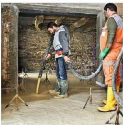
7/ Le travail de coulage s'effectue à deux personnes pour manœuvrer plus facilement le tuyau de la pompe qui s'avère lourd, et pour éviter de déplacer par mégarde les trépieds.
