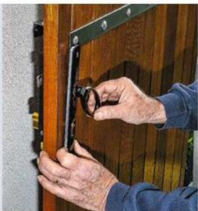
19 L'entretoise est conçue pour être vissée (vis TF M5) derrière la contreplaqué. Celle-ci étant elle-même à visser par l'intérieur, à travers le volet. Ce qui oblige à déposer la serrure...
