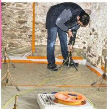
5/ L'étanchéité et les contrôles réalisés, il faut poser des trépieds de repérage à intervalle régulier sur toute la surface à couler. La hauteur de la chape est ajustée sur chaque trépied.
