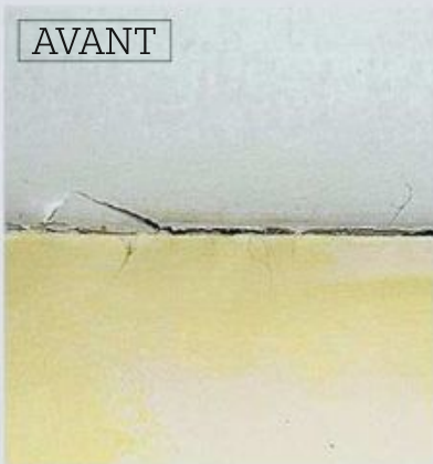
16 Après intervention, les fissures sont le plus souvent réduites, comme on le voit ici entre la phase avant injection et après. Comme pour l'extérieur, l'entreprise conseille d'attendre une année avant d'entreprendre des travaux de réfection, le temps que le bâtiment se soit parfaitement stabilisé.
