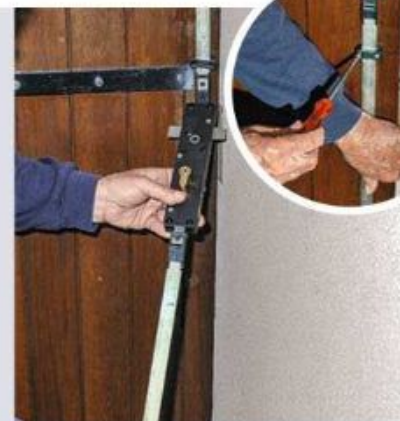
21 Revissez la serrure équipée de ses tringles, contrôlez leur verticalité au niveau à bulle, avant de visser les coulisseaux dans le tablier du volet.
