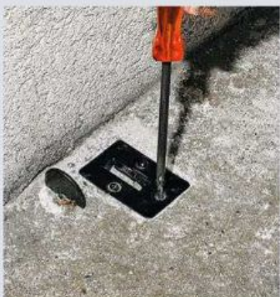
24 En bas et en haut, butées et gâches sont distinctes. Elles sont donc fixées consécutivement: d'abord les butées (en tenant compte de l'épaisseur du volet), puis les gâches qui imposent de percer la maçonnerie pour accueillir les pénes.
