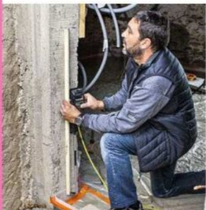
3/ À la porte d'entrée, un rail en PVC est posé au niveau du seuil pour contenir la chape. Puis, un repère est réalisé à 1 m de hauteur à l'aide d'une règle et d'un niveau à eau électronique.
