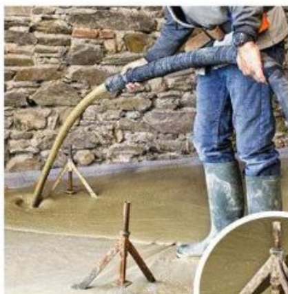
6/ Le coulage doit débiter dans le coin opposé à la sortie. Le mortier fluide s'étale entre les trépieds en place.
