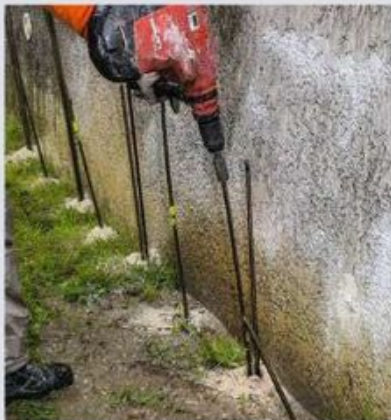
4 Dans chacun des trous qui serviront à acheminer la résine injectée dans le sol, l'opérateur introduit, à la main ou par « vibro-fonçage » – en s'aidant du perforateur en mode percussion – les tubes d'injection en acier. Des bouchons de sécurité sont placés à l'extrémité de chaque tube pour éviter aux techniciens de se blesser durant l'opération.
