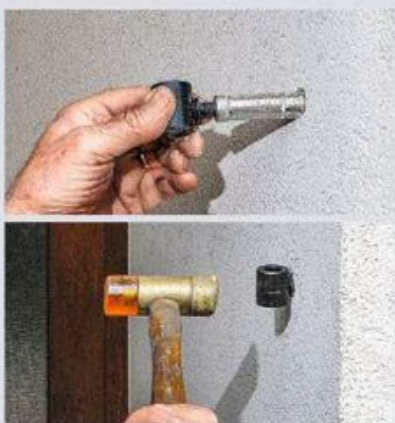
9 Utilisez des chevilles métalliques à expansion. Vissez légèrement les gonds dans les chevilles. Présentez les chevilles pour qu'elles se maintiennent puis vérifiez leur alignement. Retirez les gonds des chevilles, puis frappez ces dernières pour les faire entrer dans les trous et visser à fond les gonds. Vérifiez à nouveau leur alignement à la règle de maçon et au niveau.
