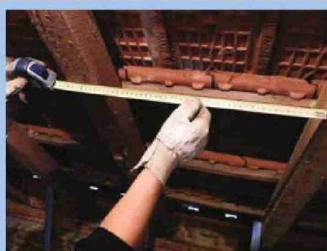
1- Mesurer l'écart entre les chevrons
