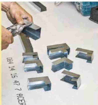
19 À la cisaille ou à la grignoteuse, découpez des sections de rail de 15 cm environ. Pratiquez une entaille à 5 cm sur les ailettes du rail, puis pliez-le pour former une équerre.
