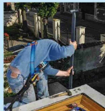
12 Mettez en place le premier poteau en glissant les cornières sur les tiges filetées des goujons.
