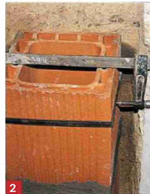
Pour éviter que le conduit ne s'incline, bridez-le avec de simples fers plats pliés et scellés au mortier dans le mur.
