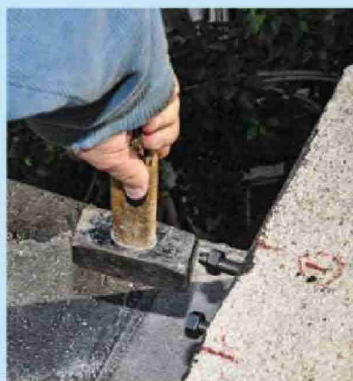
11 Enfoncez les goujons à la massette. Ils sont prévus pour être frappés sans écraser l'extrémité fileté.
