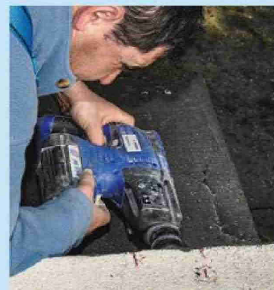
9 Percez les deux trous de fixation du premier poteau. Reliez votre harnais à un point fixe de la terrasse !
