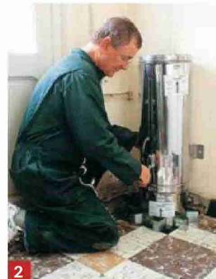
Fixez le conduit au mur par une bride métallique. L'ensemble doit être rigide et respecter l'écart au feu réglementaire.
