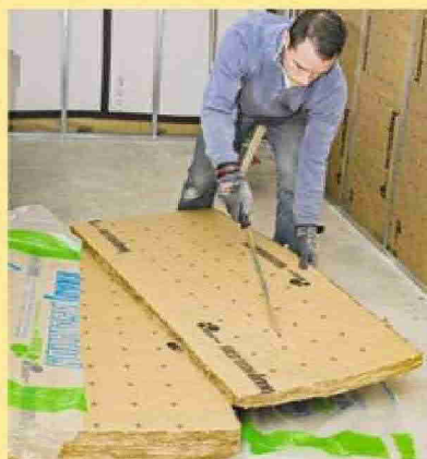
23 Découpez les lés plus étroits et les compléments de laine de verre en partie haute à l'aide d'un cutter ou d'un couteau à isolant.
