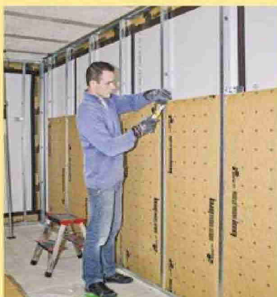
22 Placez les panneaux de laine de verre entre les montants de l'ossature métallique. Entaillez l'isolant au cutter au niveau des équerres de renfort pour une isolation continue.
