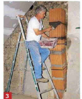
Garnissez généreusement les joints de mortier pour bien étancher le conduit. De la laine de roche complètera l'isolation.
