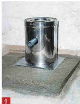
À sa base, placez le pied du conduit récupérateur de condensats et le té de ramonage sur une semelle en béton de 5 cm.
