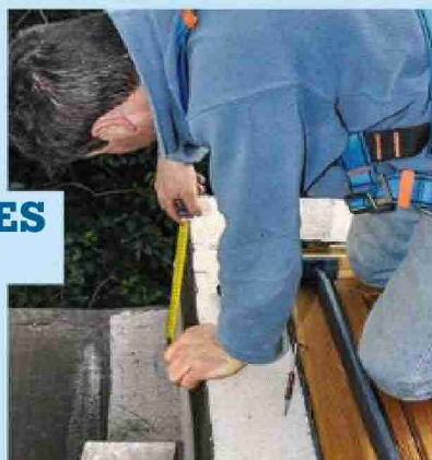
7 Le premier poteau doit être posé en retrait de l'angle car il faut prévoir l'élément coudé qui réunit les deux travées. Mesurez 35 cm à partir de l'angle.
