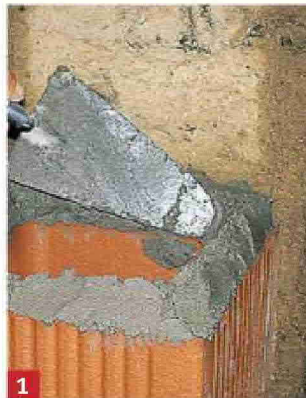
Déposez le mortier sur le pourtour du premier boisseau puis emboîtez le suivant. Lissez les joints intérieurs à la main.
