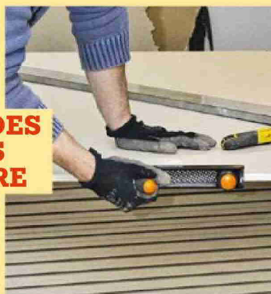
26 Mesurez la hauteur (moins 1,5 cm) entre le sol et le plafond puis découpez au cutter votre première plaque de plâtre. Passez un coup de rabot à plâtre au niveau de la découpe.
