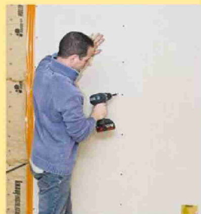
27 Sur une chute placée au sol, positionnez votre plaque de plâtre à mi-largeur des montants de part et d'autre, puis vissez-la en périphérie et au centre tous les 25 cm.
