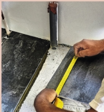
10 D'autres découpes sont à prévoir : angle sortant ou rentrant, passage de tuyaux... Utilisez un crayon gras pour les tracés et quadrillez la partie à supprimer à l'aide d'une pointe. Si la partie à éliminer est importante, commencez à découper à la meuleuse et terminez en rognant à la pince perroquet.
