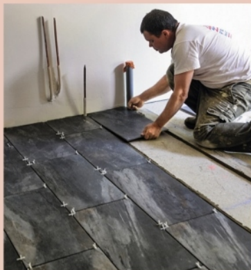
8 Posez les carreaux de la première rangée. Ajustez-les à l'aide d'un maillet en caoutchouc. Placez des croisillons d'espacement et poursuivez de façon identique la pose des rangées suivantes. Contrôlez régulièrement à la règle de maçon et au niveau l'alignement et la planéité de l'ensemble. Les découpes se font en début ou fin de rangée.
