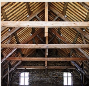
Charpente moderne de la grange d'accueil de Guédelon.
