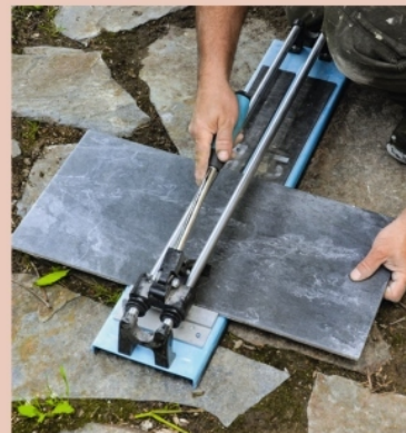
9 Pour les coupes droites, placez le carreau sur la carrelette. Posez la molette et poussez en appuyant régulièrement sur la partie du carreau à découper.
