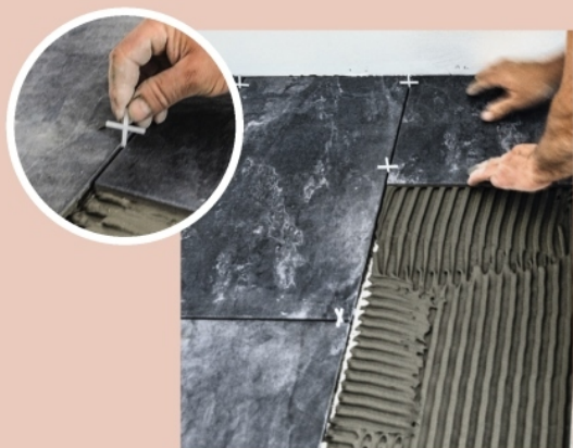
8 Posez les carreaux de la première rangée. Ajustez-les à l'aide d'un maillet en caoutchouc. Placez des croisillons d'espacement et poursuivez de façon identique la pose des rangées suivantes. Contrôlez régulièrement à la règle de maçon et au niveau l'alignement et la planéité de l'ensemble. Les découpes se font en début ou fin de rangée.
