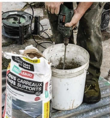
6 Gâchez le mortier-colle (idéalement, utilisez un malaxeur monté sur une perceuse). Laissez reposer le mélange quelques minutes avant de l'appliquer.
