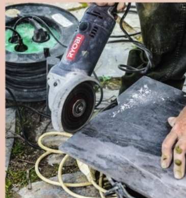
10 D'autres découpes sont à prévoir : angle sortant ou rentrant, passage de tuyaux... Utilisez un crayon gras pour les tracés et quadrillez la partie à supprimer à l'aide d'une pointe. Si la partie à éliminer est importante, commencez à découper à la meuleuse et terminez en rognant à la pince perroquet.
