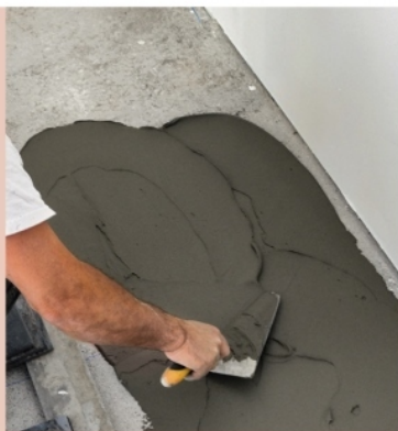
7 Étalez le mortier-colle à la truelle sur une surface correspondant à une ou deux rangées de carreaux. Striez ensuite la couche de colle, pour lui donner son épaisseur finale, à l'aide d'une spatule crantée de 10 mm.
