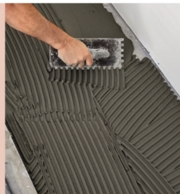
7 Étalez le mortier-colle à la truelle sur une surface correspondant à une ou deux rangées de carreaux. Striez ensuite la couche de colle, pour lui donner son épaisseur finale, à l'aide d'une spatule crantée de 10 mm.
