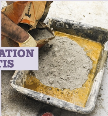
9 Le gobetis se met en œuvre une à deux semaines après l'enduit primaire, suivant l'épaisseur de celui-ci et les conditions ambiantes. Il se compose d'un volume de ciment, d'un volume de chaux hydraulique pour deux volumes de sable. Ajoutez l'eau jusqu'à obtenir un mortier fluide de la consistance d'une soupe.
