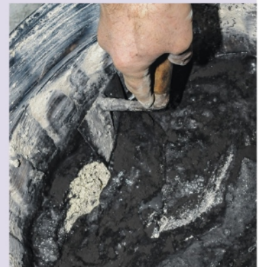
13 Mélangez au fur et à mesure avec la truelle, pour éviter la formation de grumeaux de pigments qui laisseraient des traînées à la surface de l'enduit lors de l'application.
