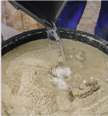
6 Mélangez à parts égales les chaux (celle de Marrakech et celle, éteinte, de type CL90). Ajoutez la poudre de marbre et l'eau. Mouillée régulièrement, cette pâte se conserve des mois.
