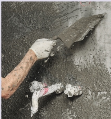
11 La surface granuleuse du gobetis est destinée à améliorer l'accrochage de l'enduit de finition. Laissez sécher à température ambiante pendant deux à trois semaines.
